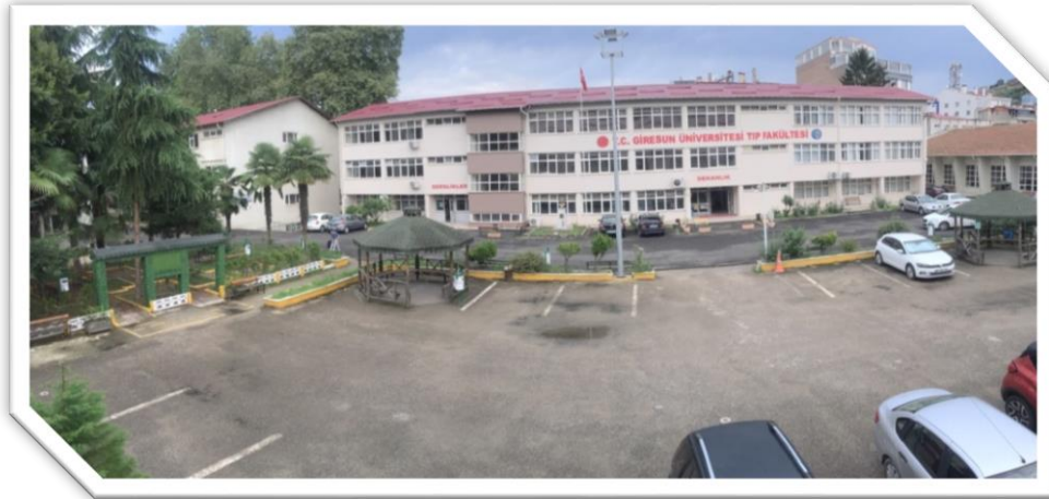
Fotoğraf- 3: Gazipaşa Yerleşkesi
